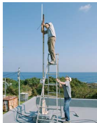
無線LANアンテナの設置
